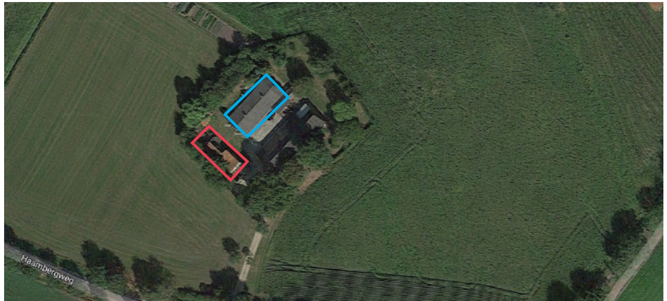
Sloop (rood omkaderd) en realisatie van zonnepanelen (blauw omkaderd) op de locatie Haambergweg 2 te Panningen. (Luchtfoto Google Maps)
