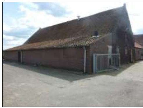
Figuur 9: Achterzijde bestaande stal
