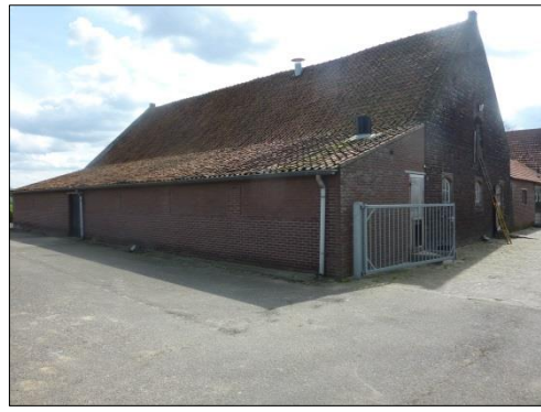
Figuur 9: Achterzijde bestaande stal
