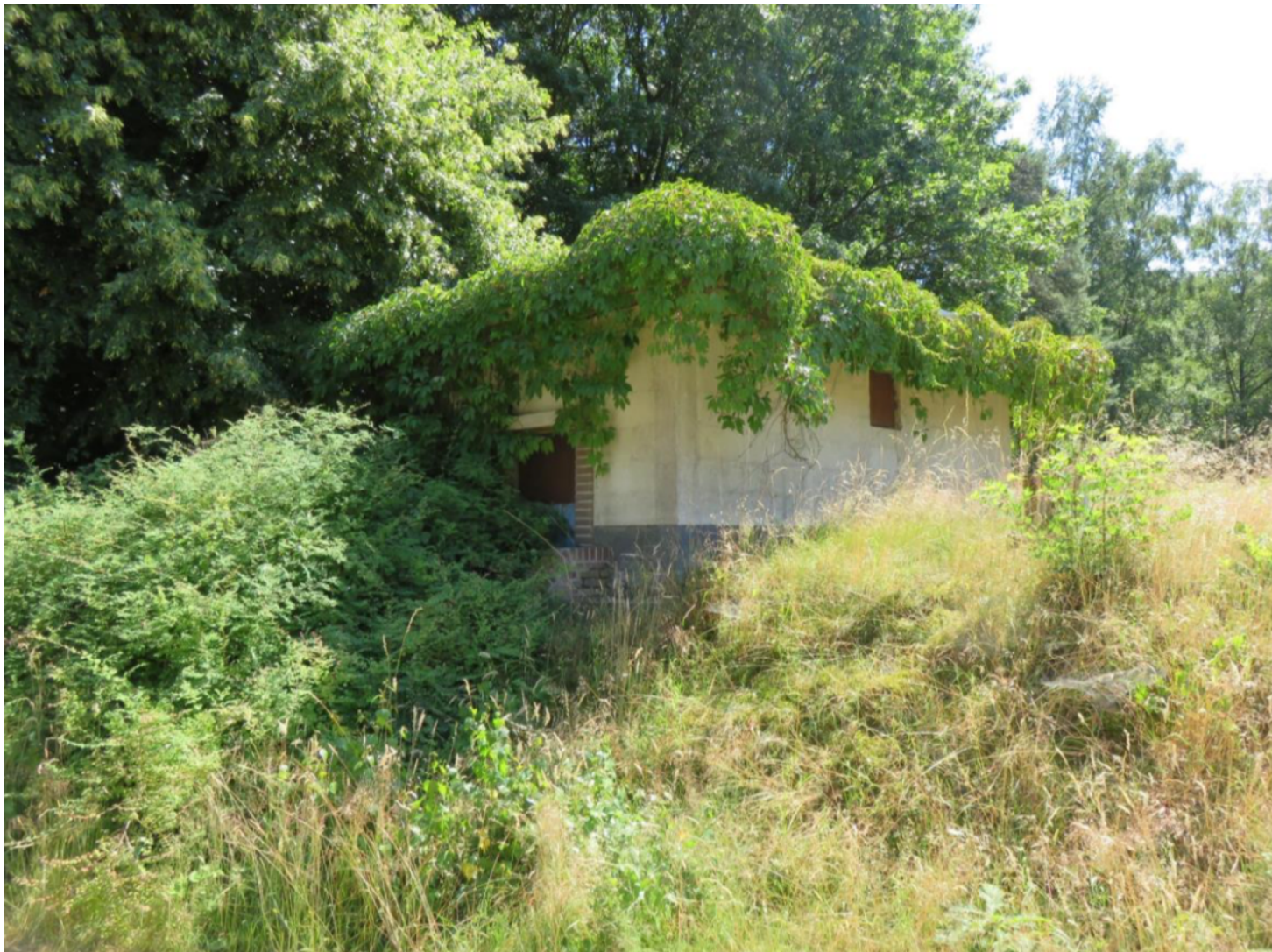
Foto 5 Impressie voormalige reinwaterkelder
