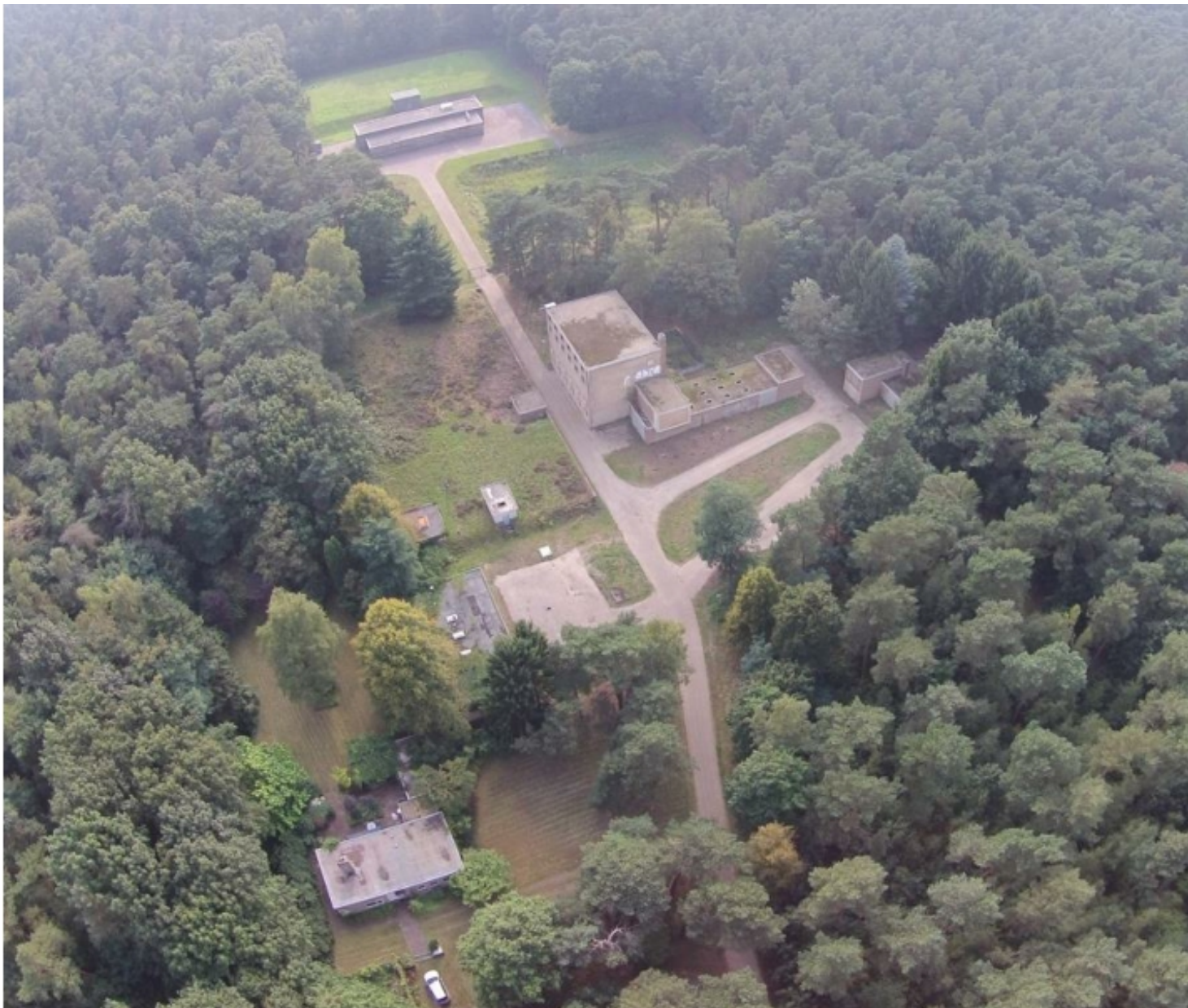
Foto 1 Voorzijde terrein: bedrijfswoning, voormalige pompgebouw, reinwaterkelders, opslagloods en kantoren. Op de achtergrond is de huidige, nog in gebruik zijnde DVI en reinwaterkelder te zien.
