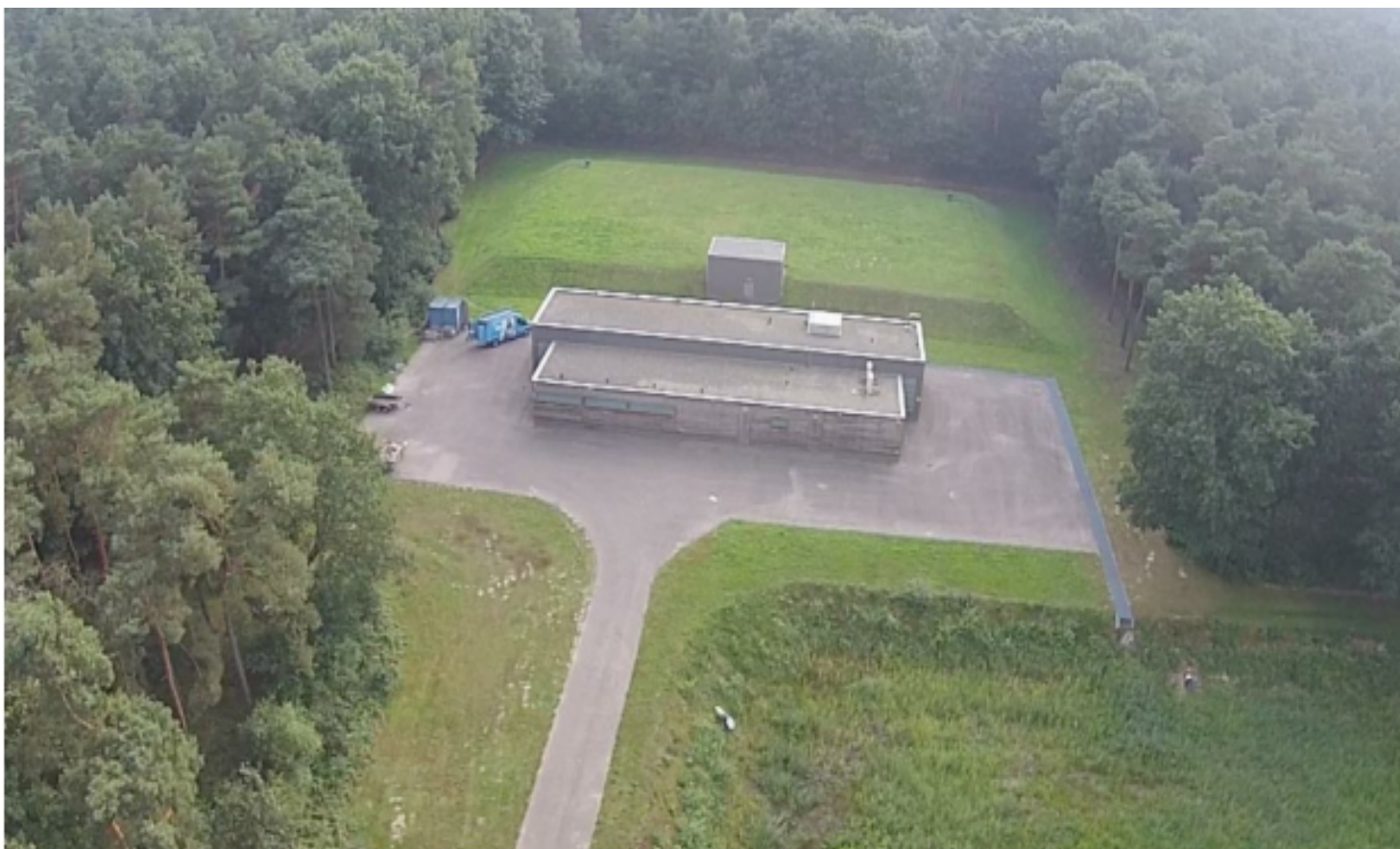
Foto 4 Achterterrein met DVI, reinwaterkelder en spoelvijver
