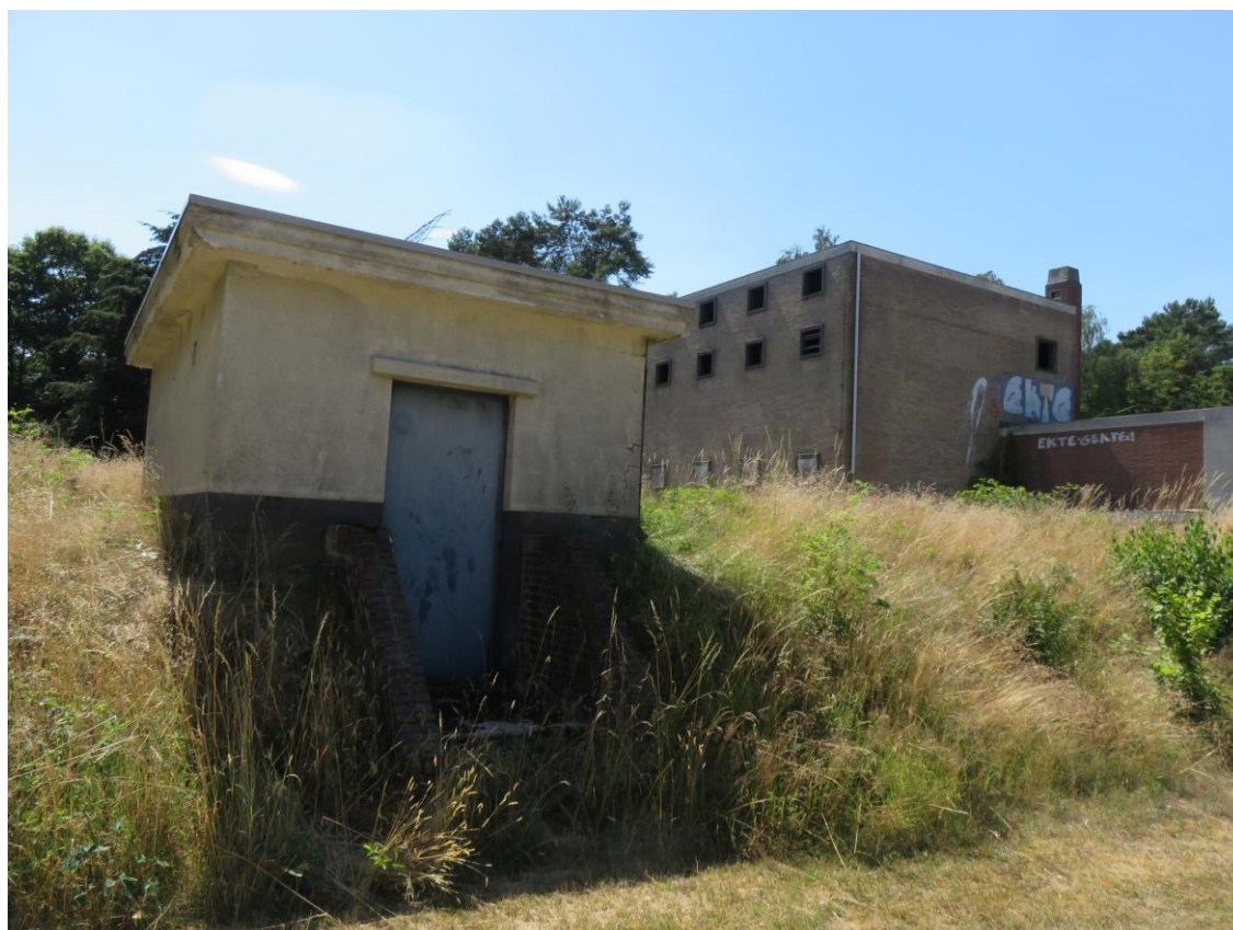
Figuur 3. Toegangsgebouw van de vleermuiskelder (gebouw 4) welke geschikt gemaakt wordt als zomer- en paarverblijfplaats voor gewone dwergvleermuizen.
