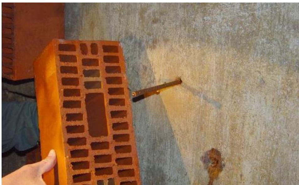
Figuur 3. Snelbouwstenen welke opgehangen worden met behulp van betonijzers vormen goede wegkruipplaatsen voor overwinterende vleermuizen.
