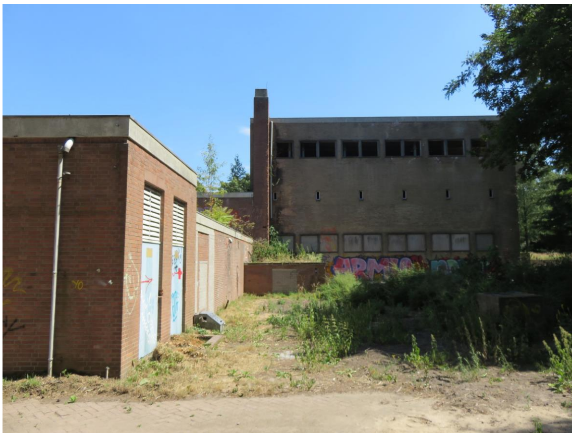
Figuur 5 Impressie gebouw 2.
