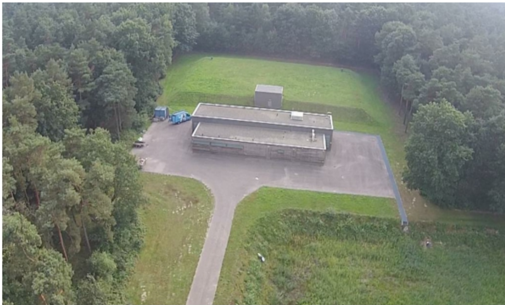
Foto 4 Achterterrein met DVI, reinwaterkelder en spoelvijver
