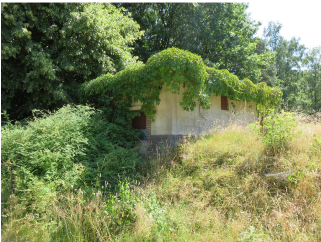
Foto 5 Impressie voormalige reinwaterkelder
