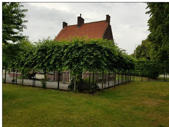
Figuur 7. Woning gezien vanaf zuiden
