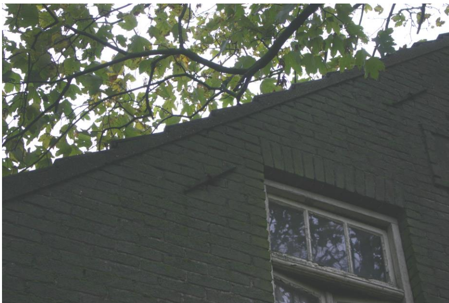
Figuur 4.5.2. De gevelpannen op de boerderij zijn in specie gelegd.
