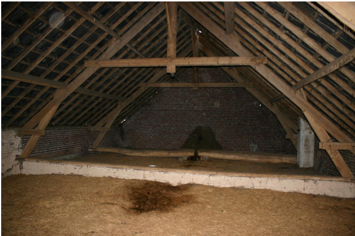
Figuur 4.5.1. De hooizolder boven de koeienstal (hier kijkt men rechtstreeks tegen de dakpannen aan).
