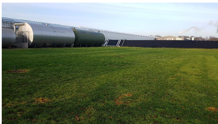
foto 3: zuidoostzijde onderzoekslocatie (10 december 2019)
