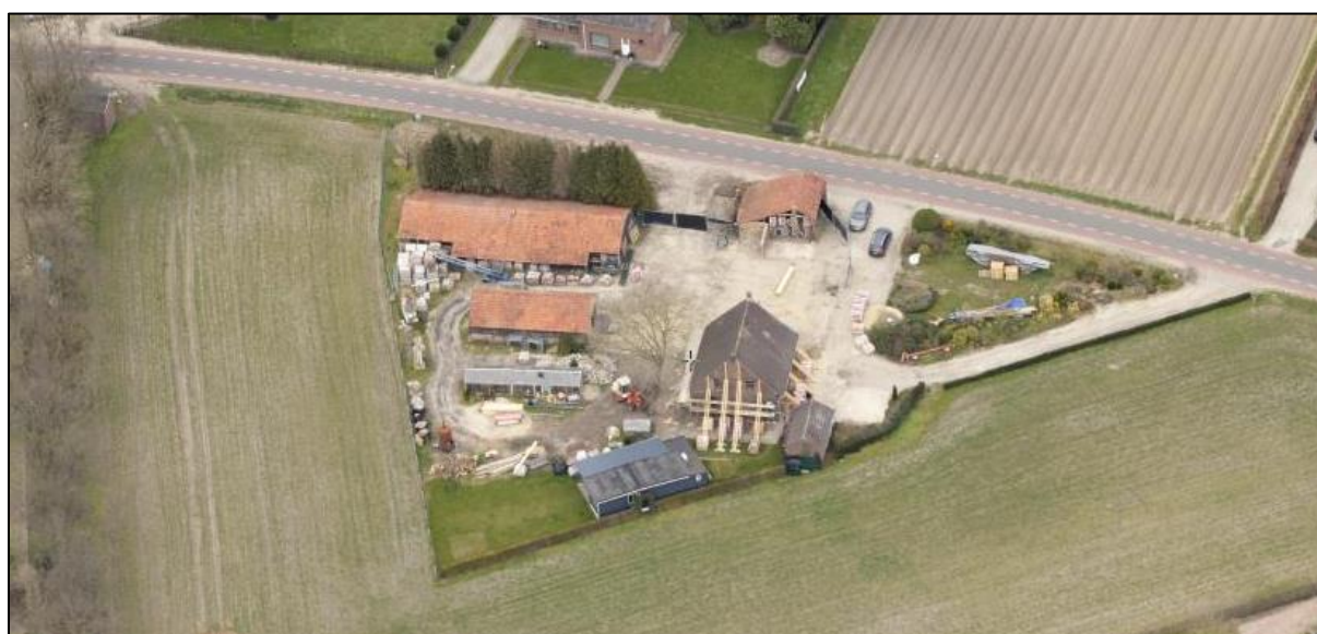
Afbeelding 9 Huidige situatie, gesloopte delen duidelijk zichtbaar
