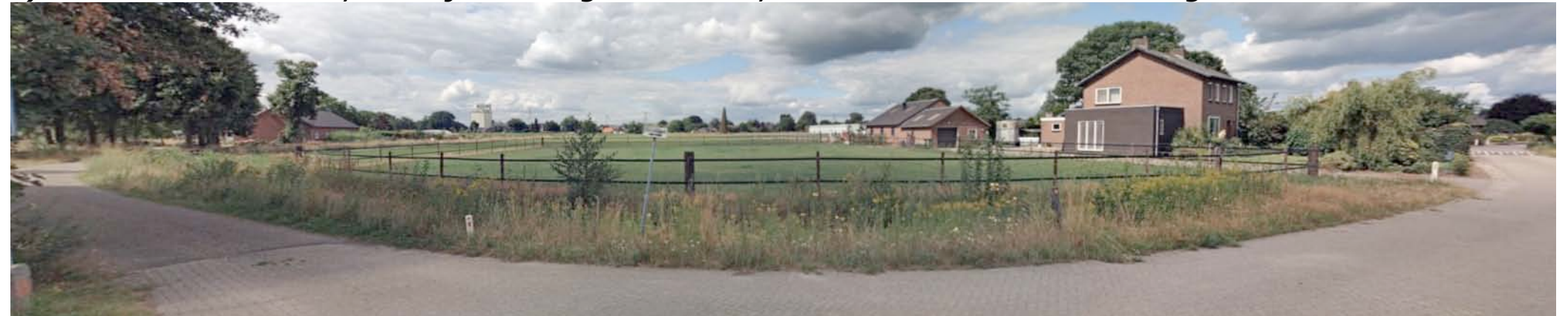
2) Vanaf de Kaumeshoek uit het noordoosten is een doorkijk mogelijk; bebouwing op buurerven is beeldbepalend.
