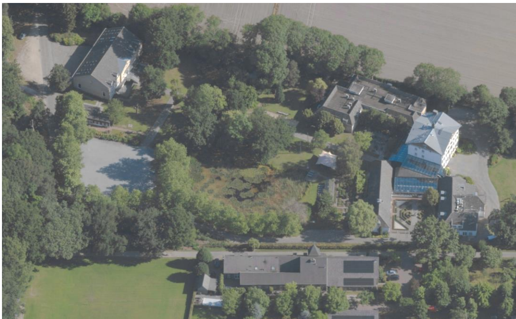
f 3.2 Luchtfoto huidige situatie (bron: Streetsmart)
