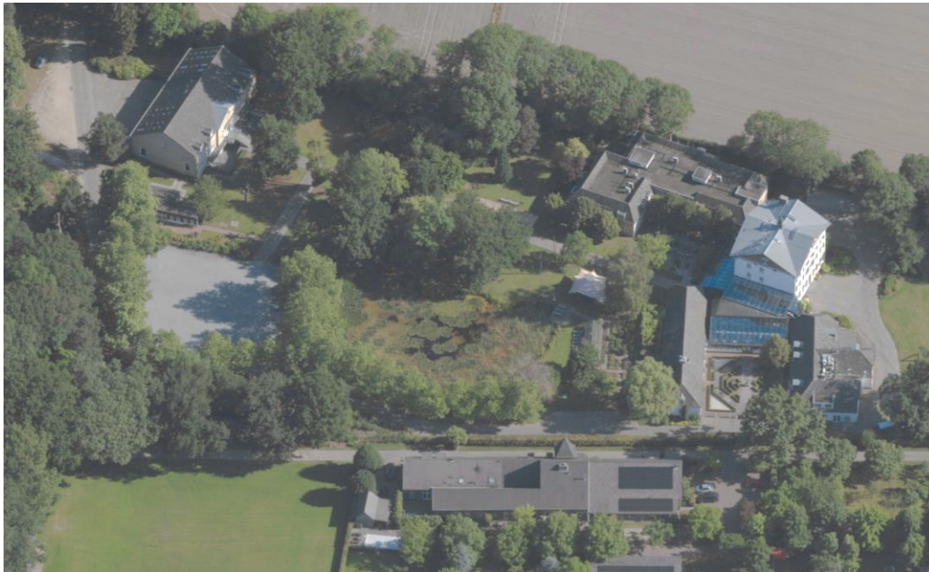
f 2.2 Luchtfoto huidige situatie (bron: Streetsmart)
