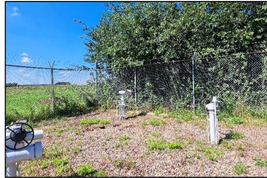
Figuur 4.3. Deel van de afsluiterlocatie waar werkzaamheden plaatsvinden.
