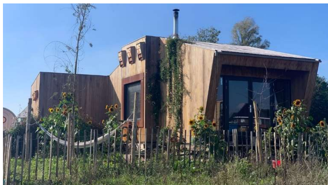
Tiny House Olst, gebogen dakconstructie en uitbouw. Let op natuur inclusieve maatregel aan gevels in de vorm van nestkastjes.
