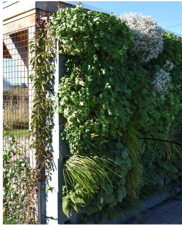
gevel groen in openbare ruimte
