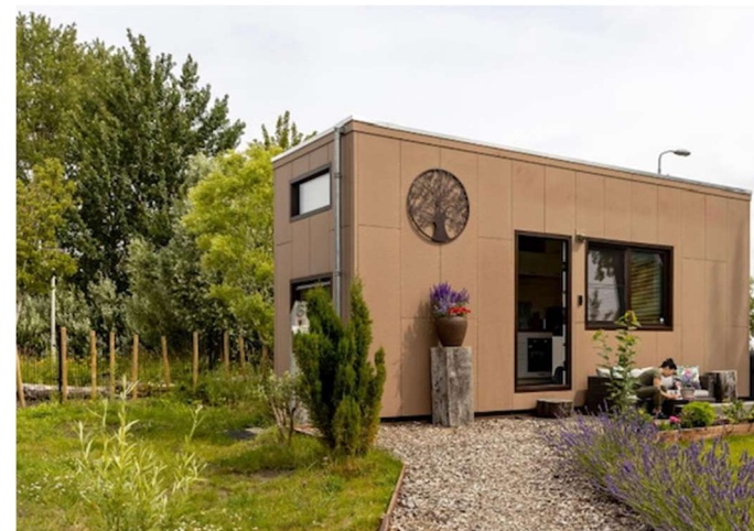
Tiny Oevers Roosendaal, afwerking buitenzijde met stenen platen die meekleuren met seizoenen.
