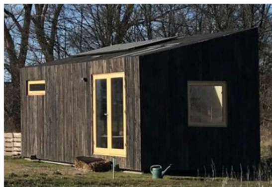
Tiny Findy, Project Klein Zuidbroek Apeldoorn.links, Combinatie van twee daksoorten, rechts toepassing gebrand hout
