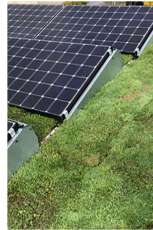
sedum dak met zonnepanelen
