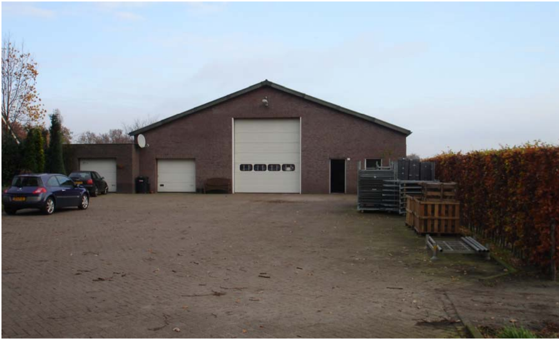
Figuur 8: Vooraanzicht loods en parkeerterrein
