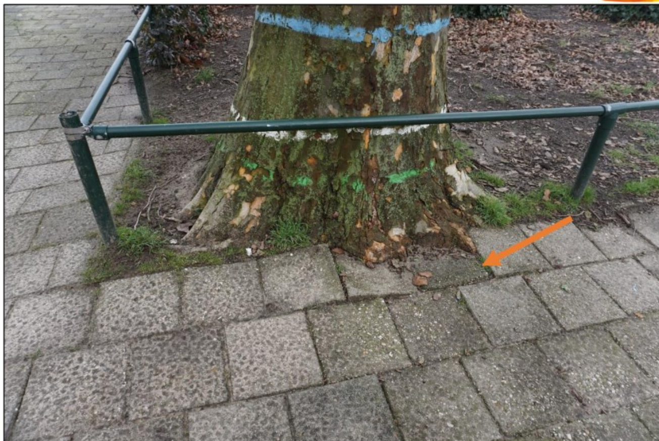
Foto 3: Een beeld van de lichte bestratingsopdruk met ingegroeide 30x30 tegels (oranje pijl) bij boomnummer 2.
