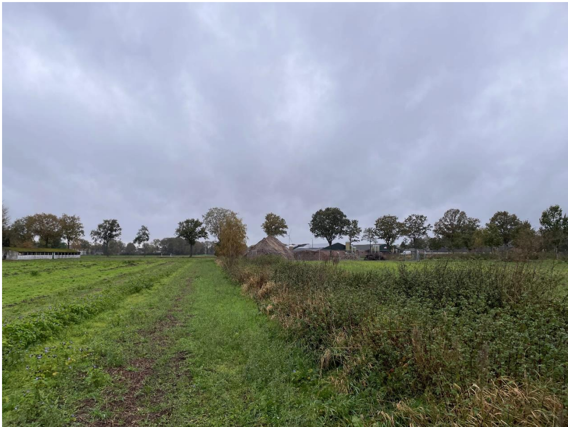
Foto 3: op de noordwest zijde van de akker werden grondwerkzaamheden uitgevoerd. In de voorgrond de sloot die te midden van de akker liep.
