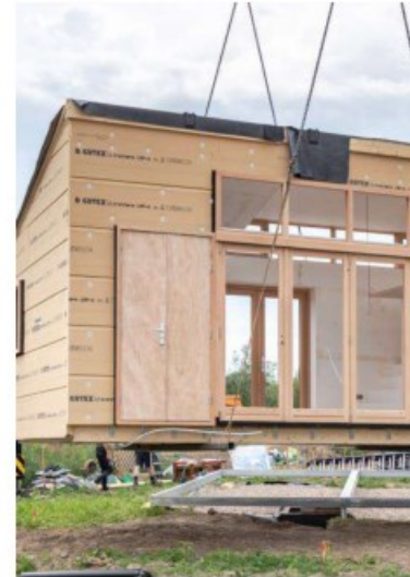
Plaatsing met kraan
