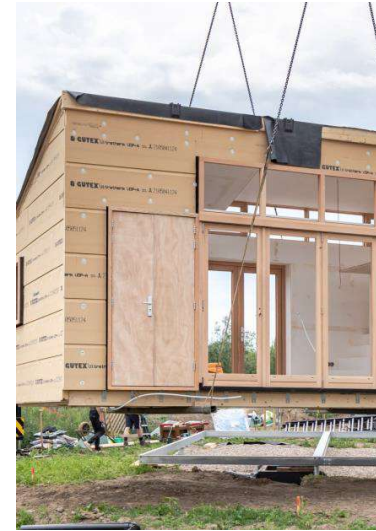
Plaatsing met kraan
