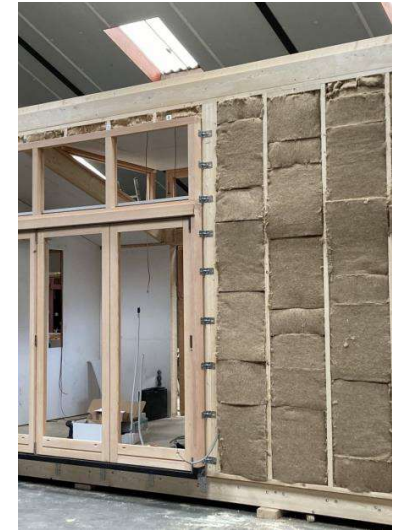
Gebruik ecologische bouwmaterialen
