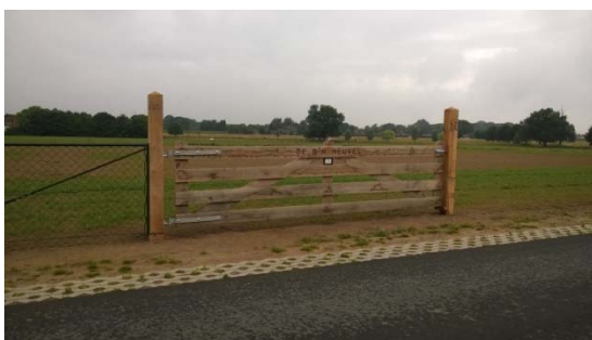
Het hekwerk is in de eerste week van juni 2015 geplaatst.
