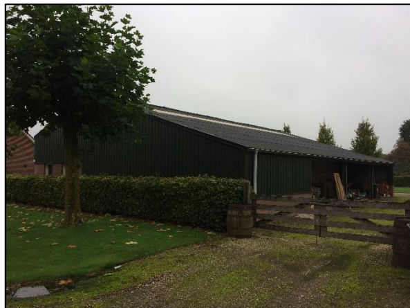
Afbeelding 5. Huidige situatie loods
