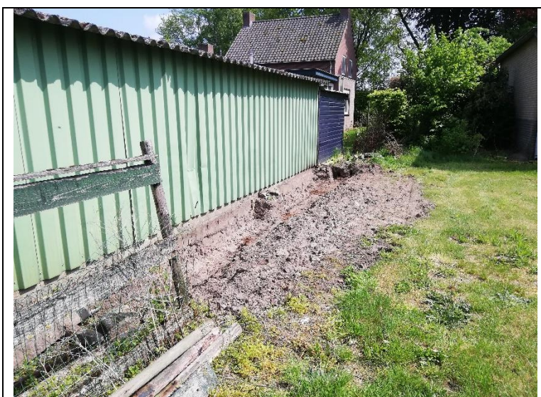
foto 2: overzicht ontgravingsput (gezien vanuit het zuidwesten, 30 april 2019)
