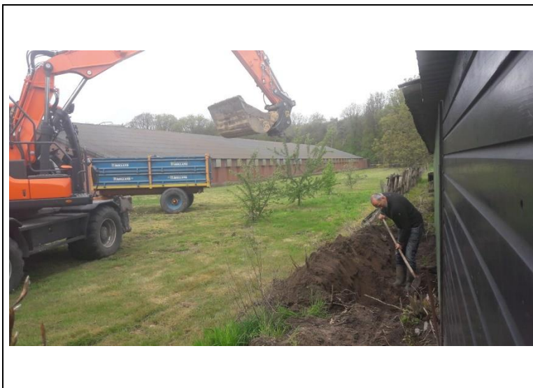
foto 1: ontgraven verontreinigd grond (gezien vanuit noordoosten)
