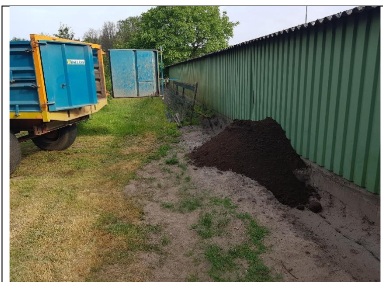
foto 3: aanvullen ontgravingsput (gezien vanuit het oosten, 25 mei 2019)
