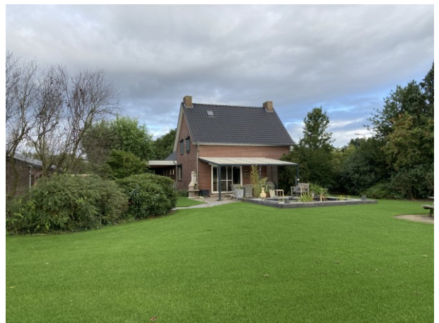
Foto 6 Woonhuis gezien vanuit oostzijde tuin
