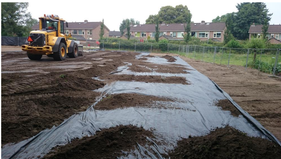
Eerste twee banen signaleringsdoek
