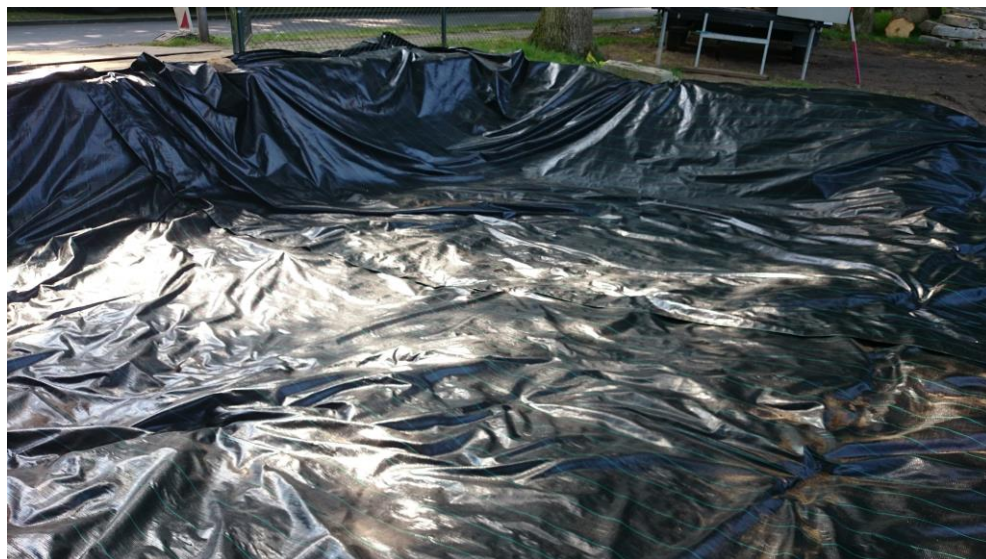
Aangebracht signaleringsdoek t.p.v. de inrit
