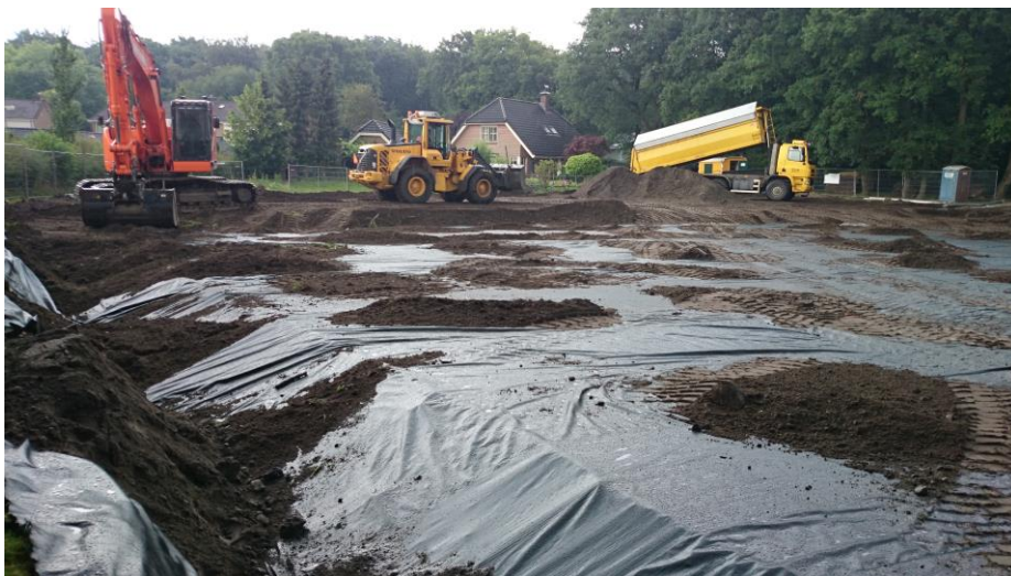
Locatie volledig afgedekt met signaleringsdoek
