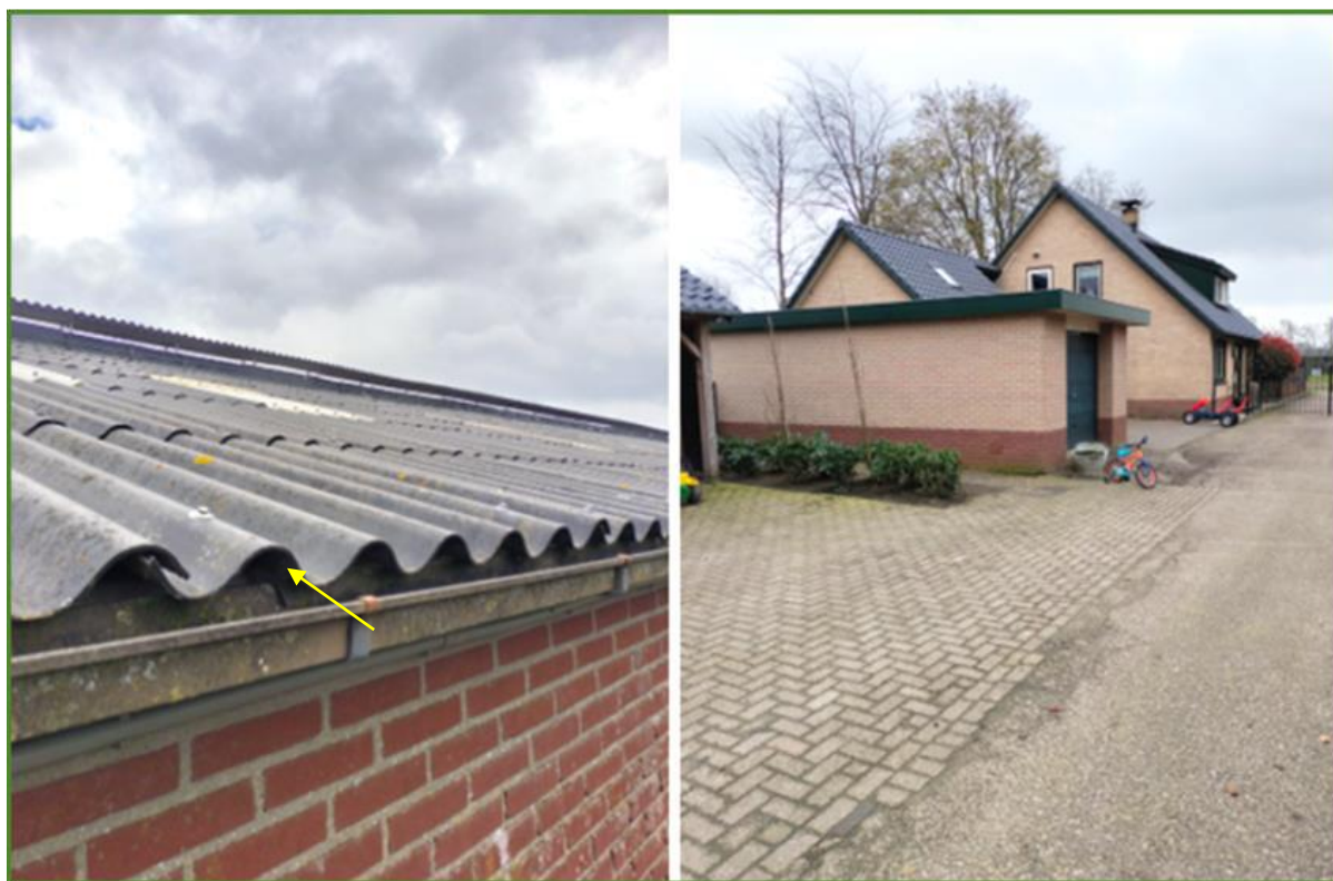
Figuur 3.1 Potentiële verblijfplaatsen (gele pijl) onder het dak van de te amoveren stallen en de te behouden woning net buiten het plangebied.
