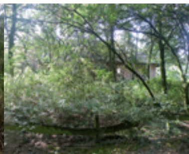
Zicht op de woning vanaf Oude Prinsenweg
