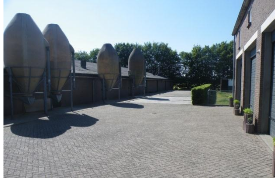
Bedrijfsbebouwing grenzend aan de elzensingel
