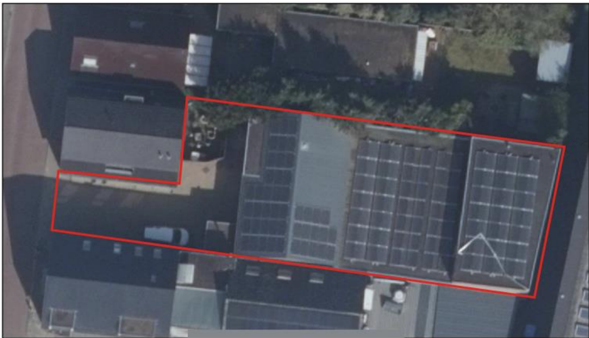
Afbeelding 2.1 Luchtfoto huidige situatie plangebied (Bron: P-dok)
