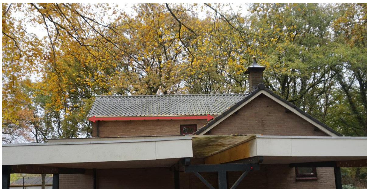
Figuur 6.2. De onderste rij dakpannen die toegankelijk zijn voor eventuele nestlocaties van de huismus.
