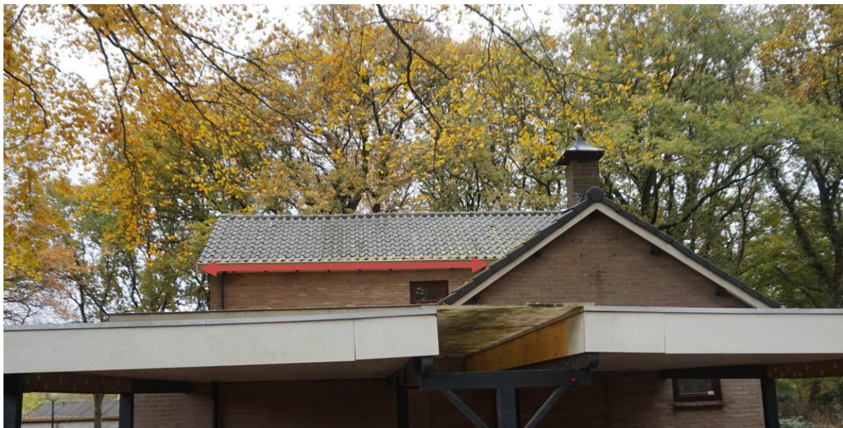
Figuur 6.2. De onderste rij dakpannen die toegankelijk zijn voor eventuele nestlocaties van de huismus.
