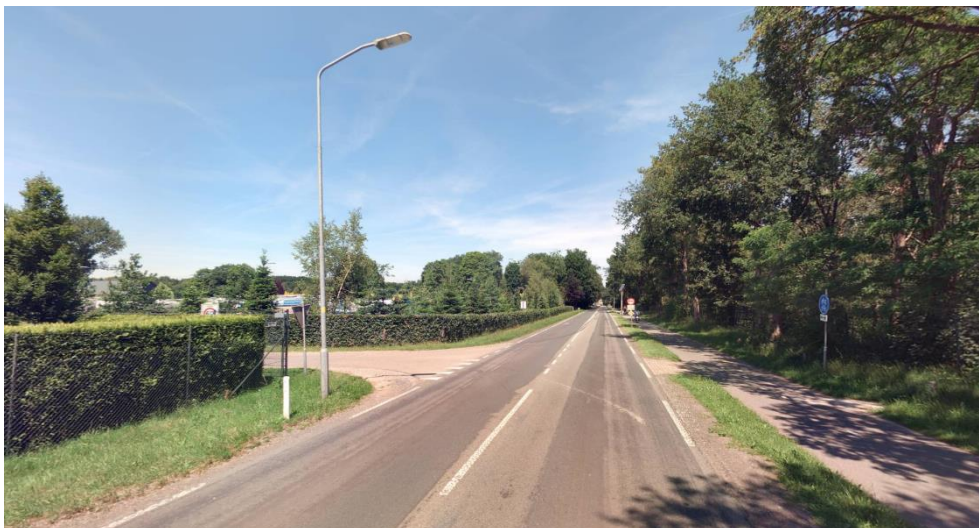
Figuur 3: aansluiting van de Koekamperweg op de Voorthuizerstraat (foto Cyclomedia 2022)
