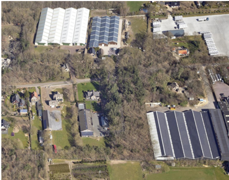
Huidige situatie omgeving plangebied (Notitie raadscommissie, 3 september 2021)
