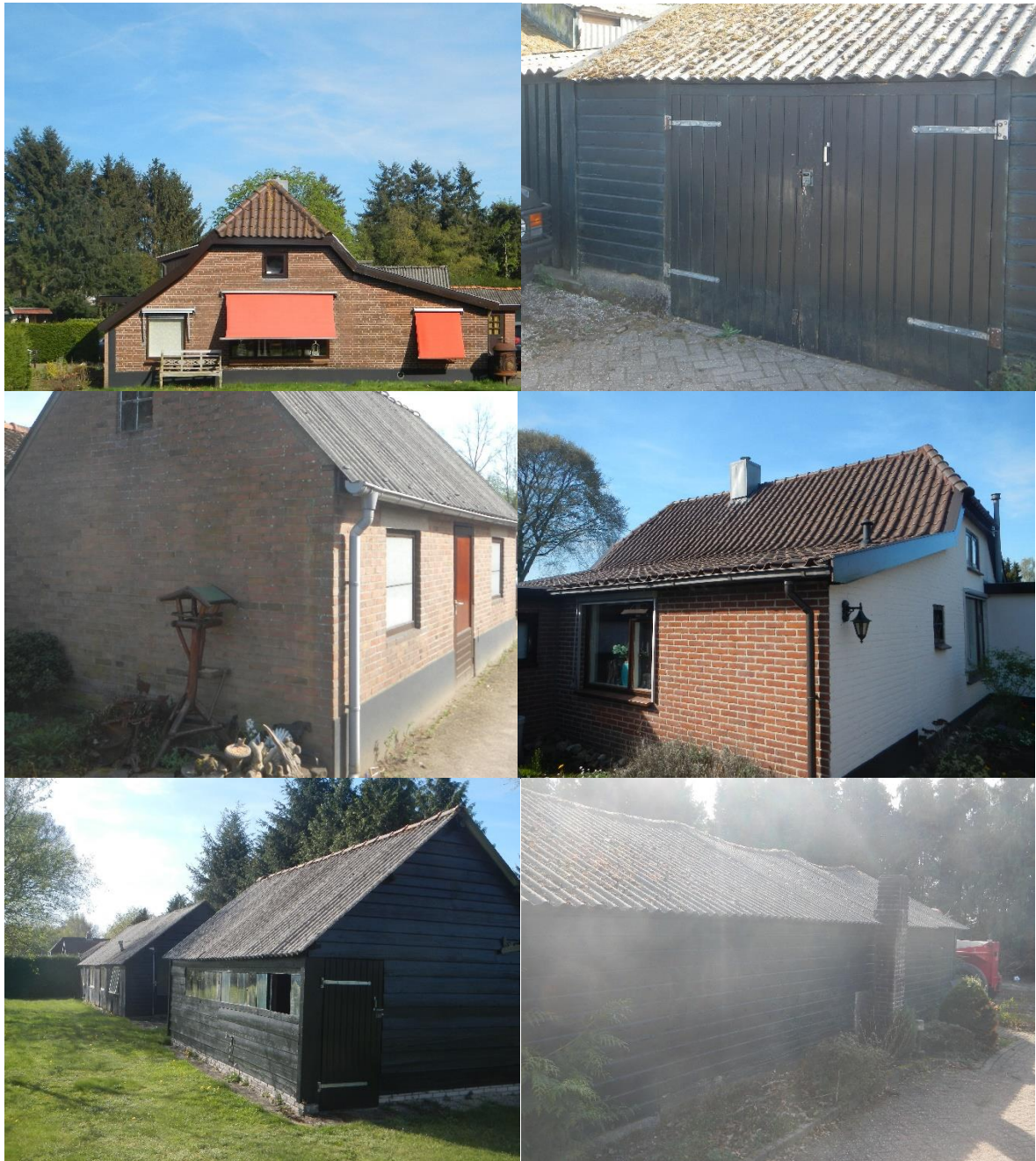
Figuur 3. Foto's plangebied met de te slopen opstallen.
