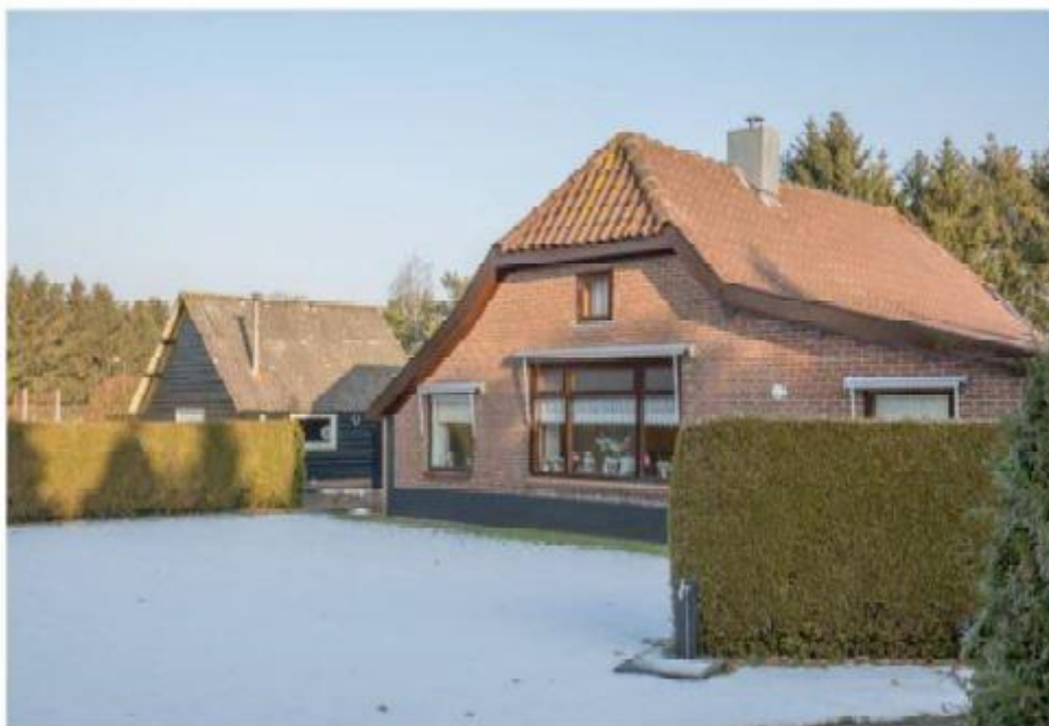
Figuur 3.2: Bestaande woning
