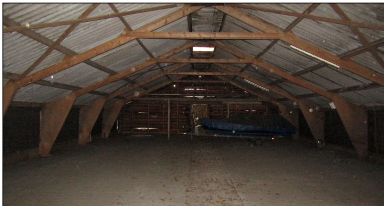
Figuur: overzicht van de binnenkant van de meest oostelijke schuur. De muur bestaat uit een enkele laag houten planken en het plafond is eveneens enkellaags. Er zijn dus geen geschikte verblijfplaatsen voor vleermuizen aanwezig.
