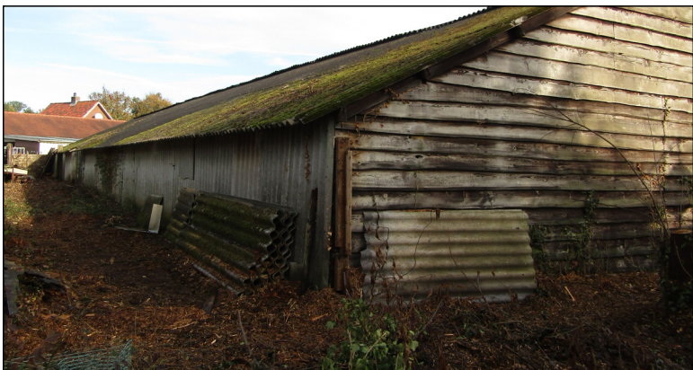
Figuur: de enige mogelijke invliegopeningen voor vleermuizen zitten op circa 1,6 meter hoogte. Deze geringe hoogte, in combinatie met andere factoren, zoals de aanwezigheid van ratten, maakt het onwaarschijnlijk dat vleermuizen hier gebruik van maken.
