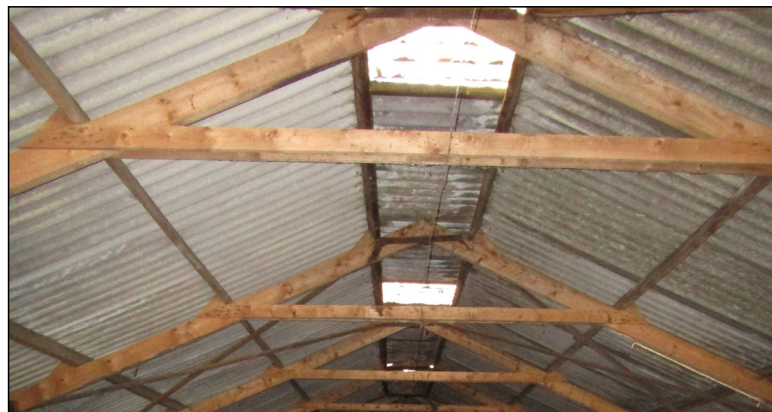
Figuur: in het midden van het dak zit om de paar meter een dakraam, welke niet begroeid zijn met mos of alg, waardoor ze goed licht doorlaten. Dit maakt het onwaarschijnlijk dat vleermuizen hier een verblijfplaats hebben.
