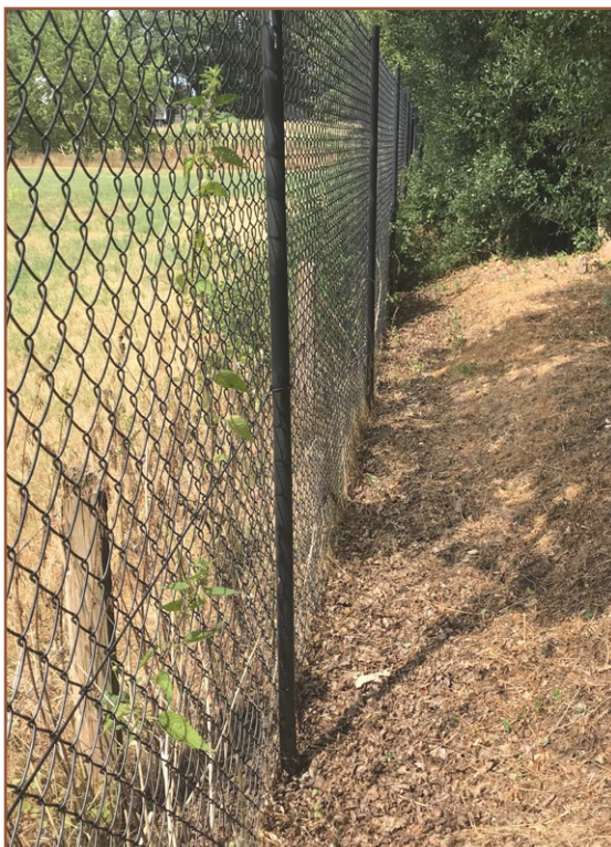
Afb. 2.3: Beeld van het gaaswerk tussen het weide-perceel en de huidige begraafplaats.
