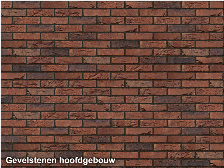
Bestaande gevelmaterialen en keuren
