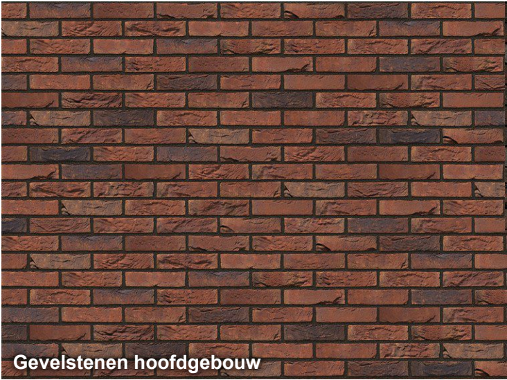
Bestaande gevelmaterialen en keuren
