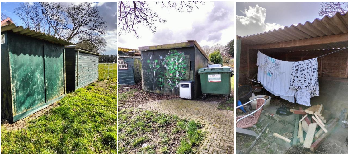
Foto 10,11,12 bijgebouwtjes/opslagruimtes geen sporen van beschermde soorten aangetroffen.
