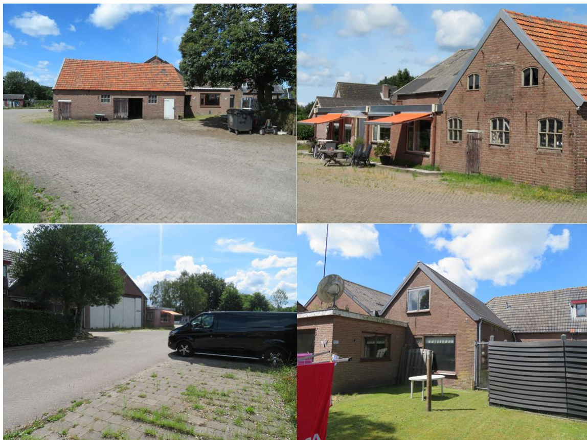
Figuur 3: Woning met aanbouwen (2)
