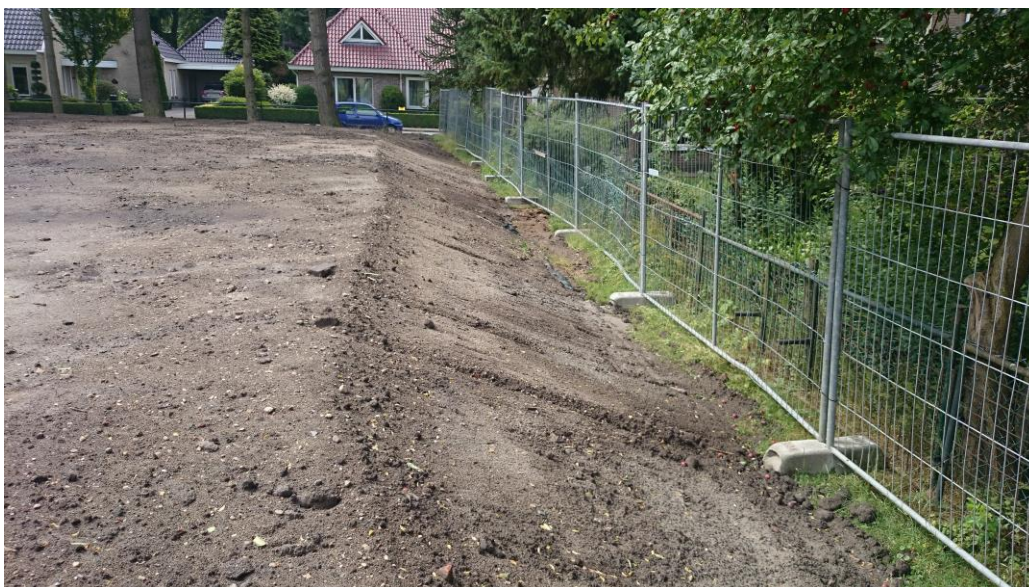
Afgewerkt talud oostzijde locatie
