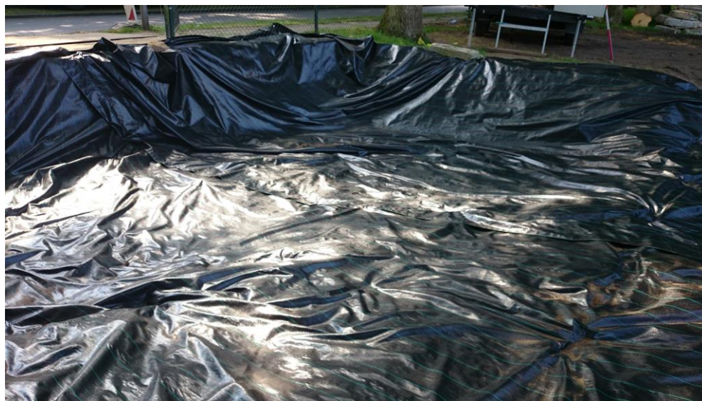
Aangebracht signaleringsdoek t.p.v. de inrit
