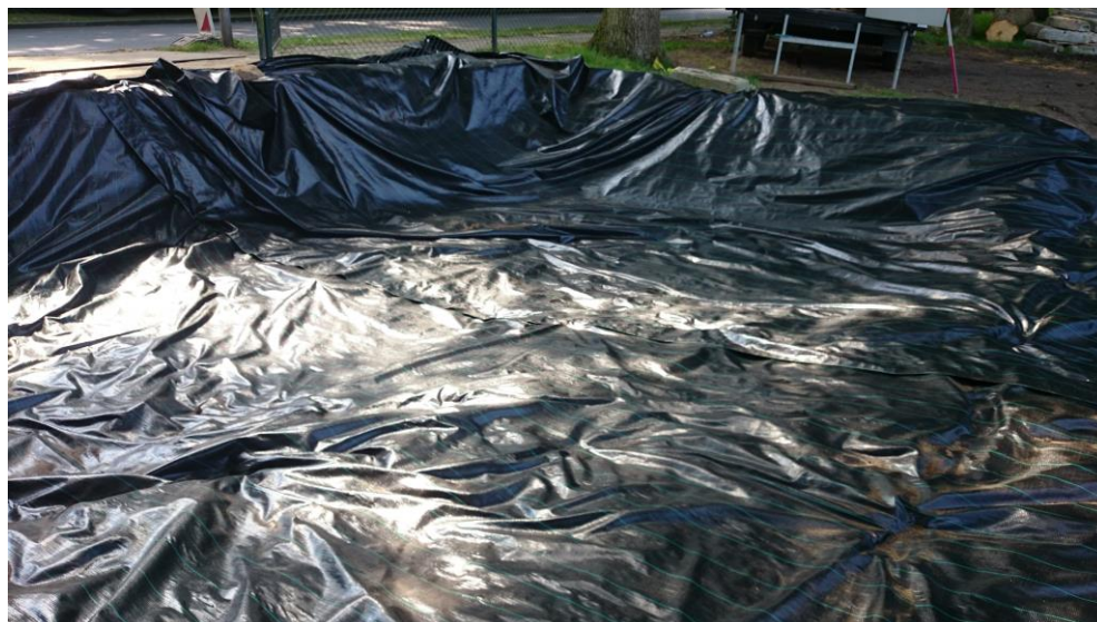
Aangebracht signaleringsdoek t.p.v. de inrit
