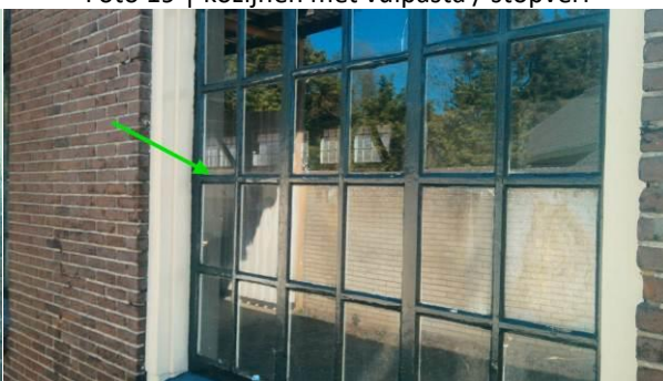
Foto 21 | kozijnen met vulpasta / stopverf
