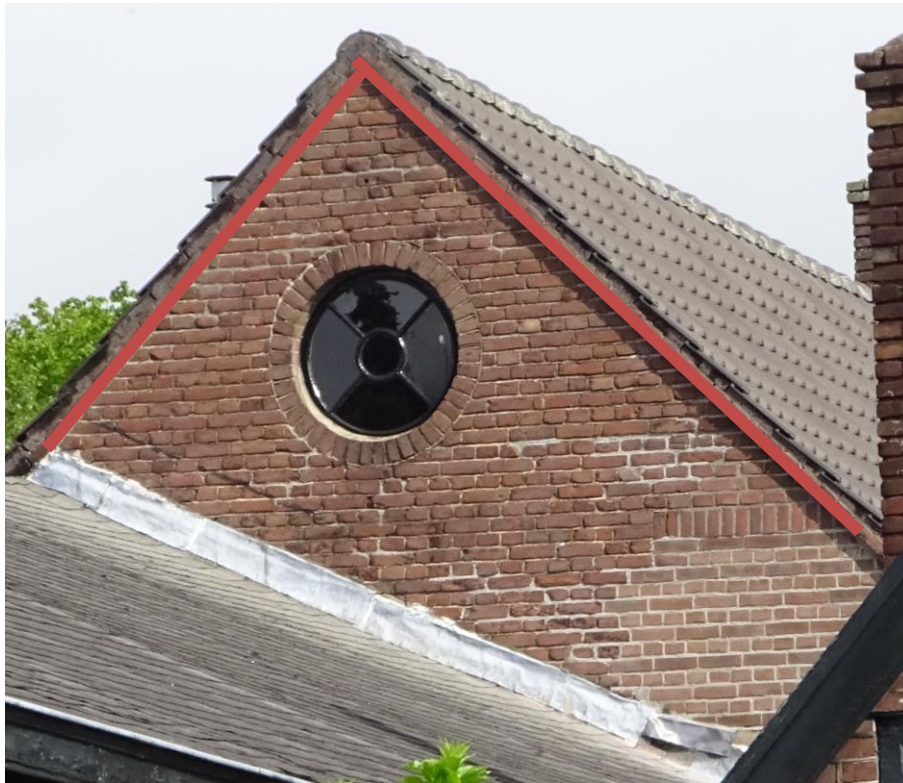
Figuur 4.4. Aansluitende gevel straks afgewerkt met specie.
