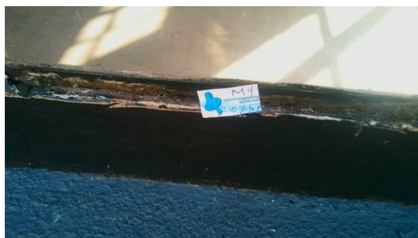
Foto 18 | kozijnen met vulpasta / stopverf
