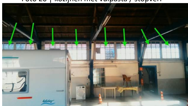
Foto 22 | kozijnen met vulpasta / stopverf
