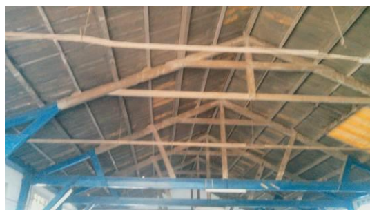
Houtenkapconstructie
