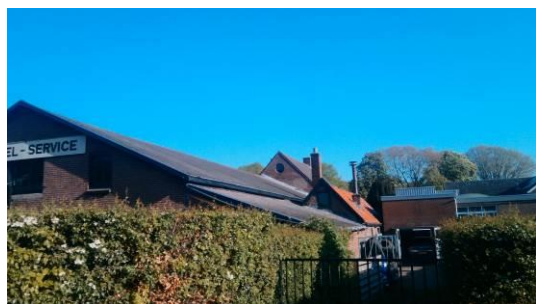
Dakshingles niet asbestverdacht
