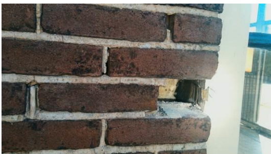
Spouw destructief, niets aangetroffen
