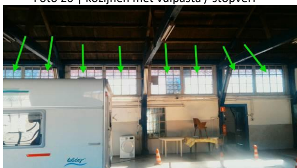
Foto 22 | kozijnen met vulpasta / stopverf
