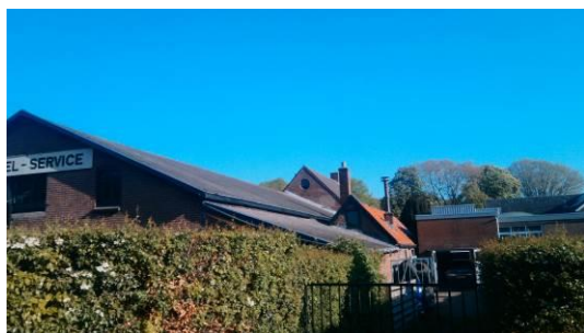
Dakshingles niet asbestverdacht
