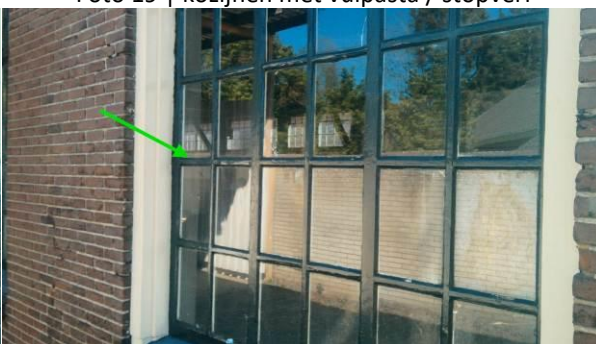
Foto 21 | kozijnen met vulpasta / stopverf
