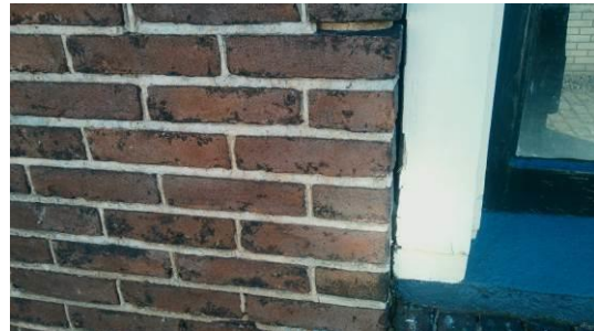
Tussen kozijn en muur spouw gezien
