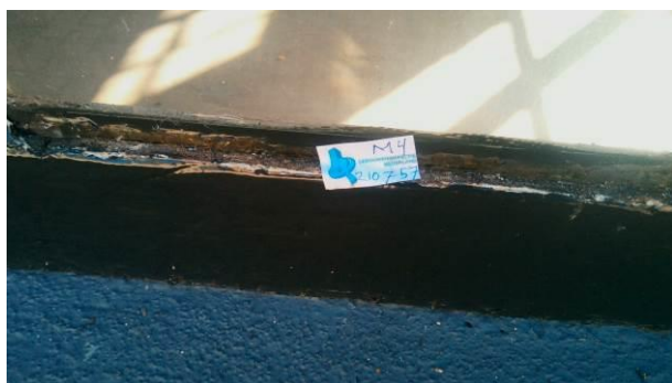
Foto 18 | kozijnen met vulpasta / stopverf
