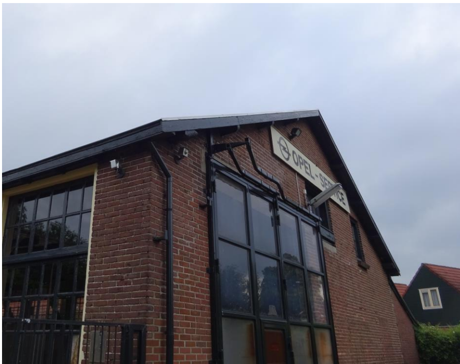
Figuur 4.3. Zuidzijde gevel van de te slopen loods.
