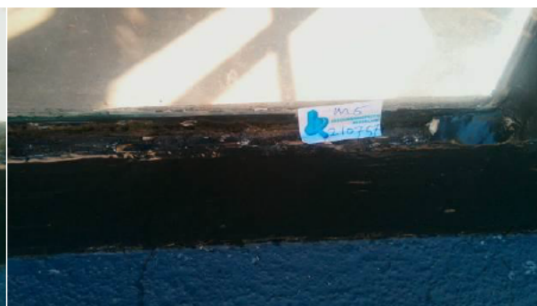
Foto 19 | kozijnen met vulpasta / stopverf
