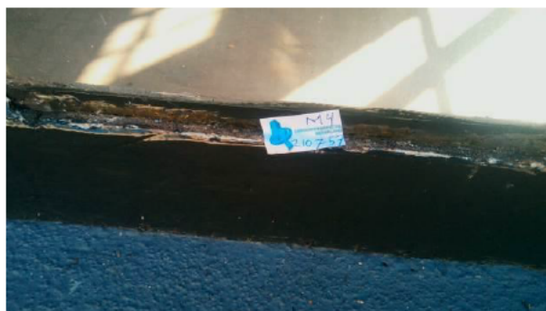
Foto 18 | kozijnen met vulpasta / stopverf
