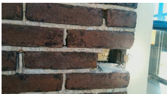
Spouw destructief, niets aangetroffen
