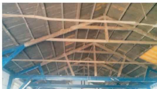
Houtenkapconstructie
