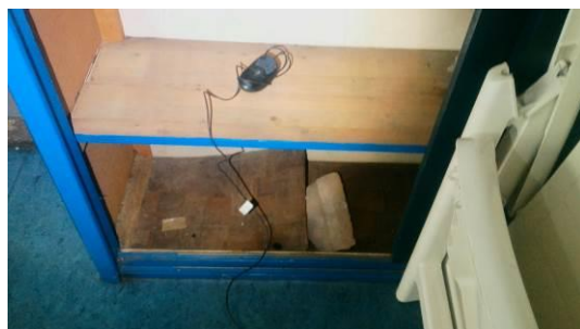
Kast kantoor zeil niet asbestverdacht
