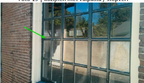
Foto 21 | kozijnen met vulpasta / stopverf
