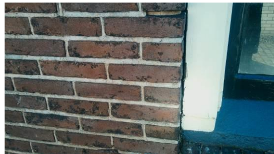
Tussen kozijn en muur spouw gezien
