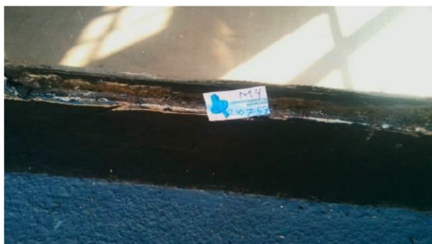
Foto 18 | kozijnen met vulpasta / stopverf
