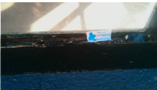
Foto 19 | kozijnen met vulpasta / stopverf
