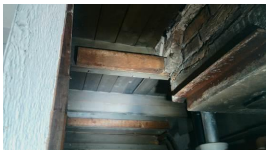
Schoorsteen en houten balklaag
