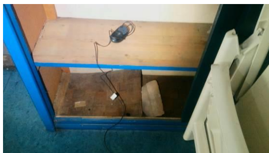
Kast kantoor zeil niet asbestverdacht
