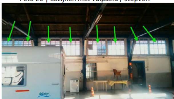
Foto 22 | kozijnen met vulpasta / stopverf
