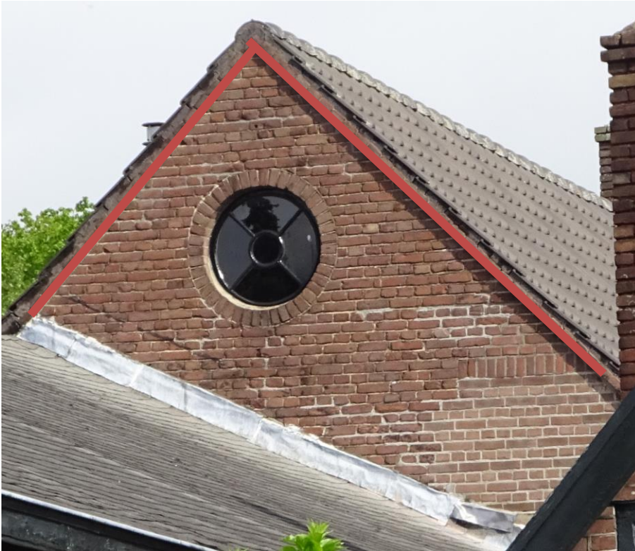
Figuur 4.4. Aansluitende gevel straks afgewerkt met specie.
