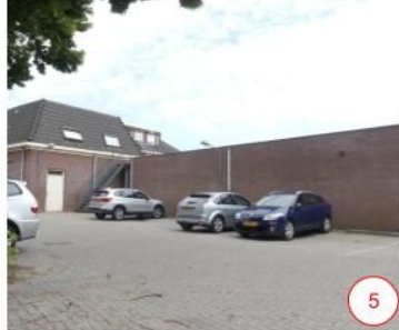
Foto 5: Dit is de achterzijde van het Boni-complex met een platdak, met muren zonder ramen of nissen. Er is een kale stenige parkeerplaats aanwezig.
