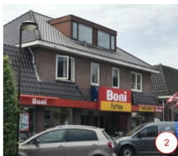
Foto 2: De bovenste verdieping van het Boni-complex heeft een dakkapel (voor en achter, zie ook foto 5) en breed overstek. Hoewel de verf op sommige plekken loslaat, zijn er geen gaten.
