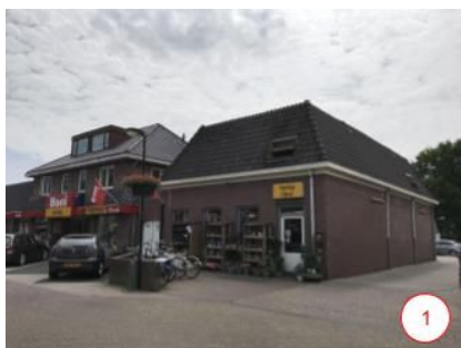
Foto 1: De Boni en het gebouw van de flora-winkel er naast hebben daken met dakpannen zonder naden en met een brede dakgoot. De Boni heeft 2 vlaggen, de Flora 1 vlag.
