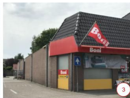
Foto 3: Noordoostelijke dak is steil en heeft keramische perfect sluitende dakpannen. Ook is er een wapperende Boni-vlag. Er zijn geen gaten, kieren aanwezig.
