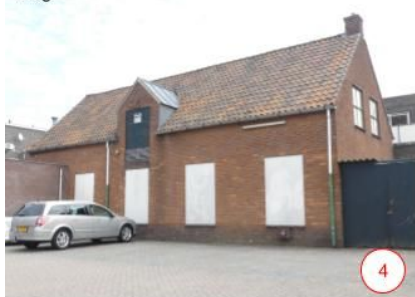
Foto 4: Dit oude gebouw grenst aan de parkeerplaats van de Boni (oostzijde) en heeft een dakpannen dak dat geschikt is voor Huismus; aan de kopse kant bij de laatste rijd dakpannen is een opening aanwezig waardoor een Huismus zou kunnen.
