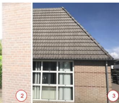
Foto 3: Dit dak is schuin genoeg voor het aanvliegen van gierzwaluwen. Als huismussen onder de hoekdakpannen kunnen komen zou het geschikt kunnen zijn als verblijfplaats, maar kieren zijn echter niet vastgesteld.
