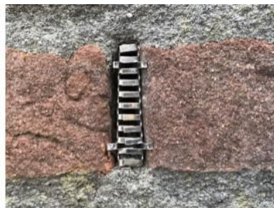
Foto: De spouwgapen van de muren zijn voorzien van 'bijenbekjes'. Dit voorkomt gebruik van wespen en dergelijke, maar ook het gebruik van vleermuizen.
