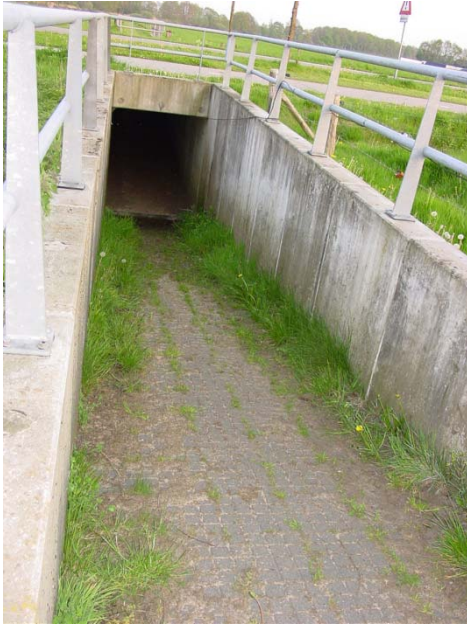
Figuur 6.3 Veetunnel: qua dimensies geschikt voor vee én das, maar de ondergrond moet anders (zie Figuur 6.4). Bron: Panorama.
